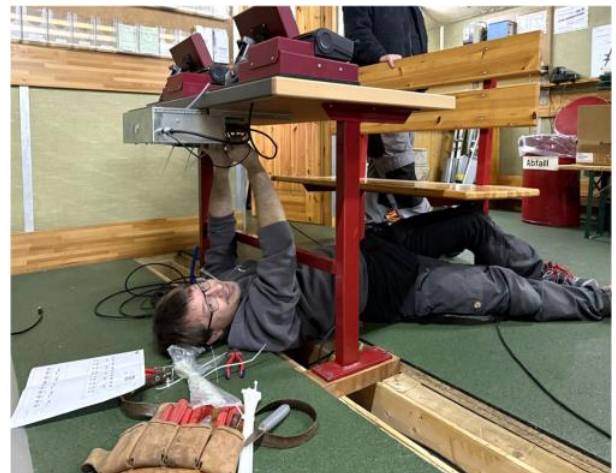
und Kabel verlegen und verlegen.....
