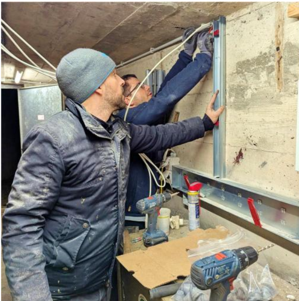
nun heisst es Kabelkanäle legen
