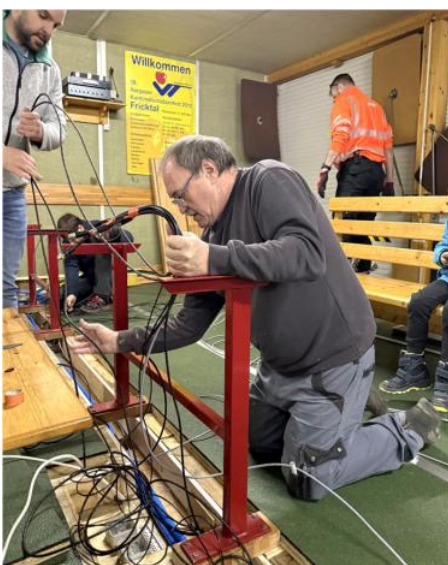
und noch mehr Kabel verlegen
