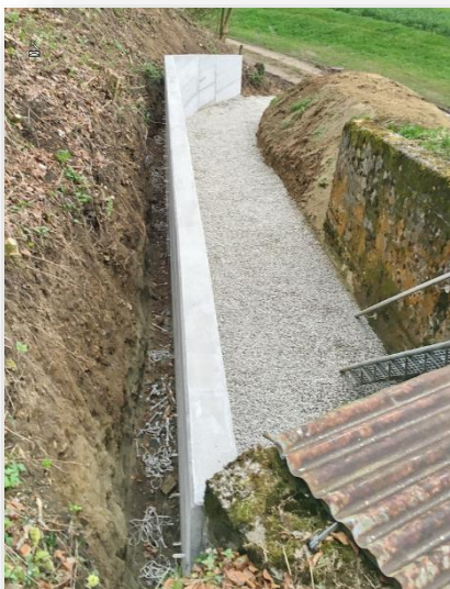
Genug Platz hinter der Mauer
