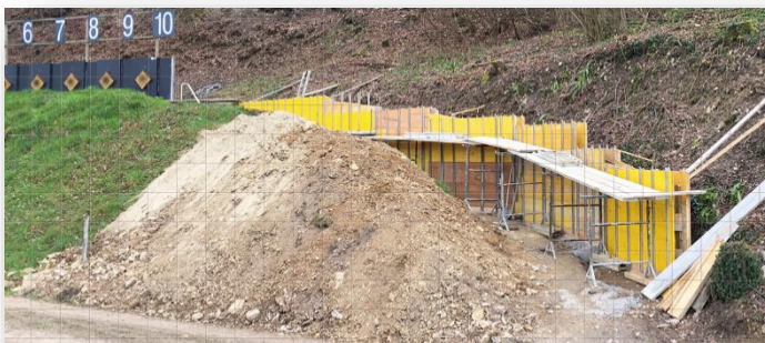
Die Schalung für die Stützmauer
